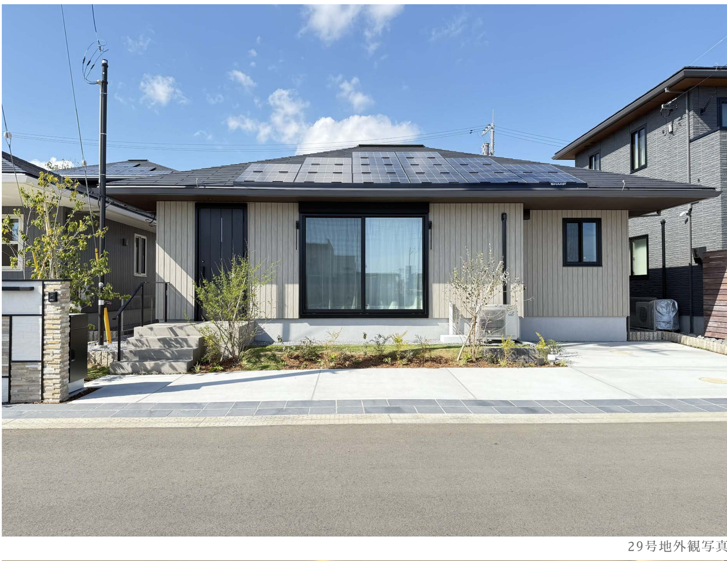
29号地外觀写真
