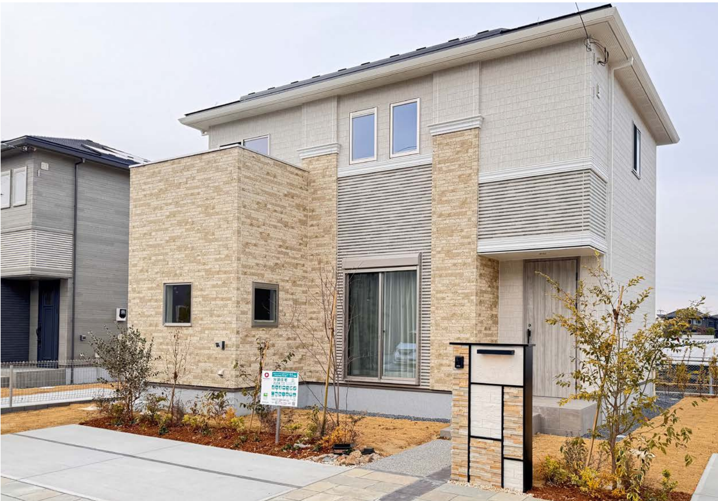
11号地外観写真
